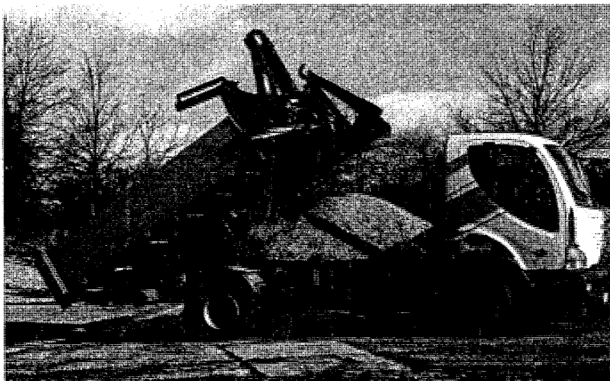
U kážka montáže natahováku a montáže hydr. ruky na kontejner.5/2008
